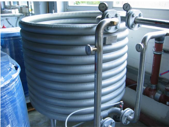
Durch den Einsatz eines Abwasser Wärmetauschers wird das Frischwasser auf ca. 28 °C aufgewärmt. Diese Temperatur bleibt dem Rückgewinnungsprozess erhalten. Und die Wäsche kann vorgewärmt weiterverarbeitet werden. Der Cool Down kann auf ein Minimum reduziert werden, da es bei warmem Wasser kein Kälteschock geben kann. Wir kommen in den meisten Fällen mit einer Baderhöhung nach der Klarwäsche aus.
