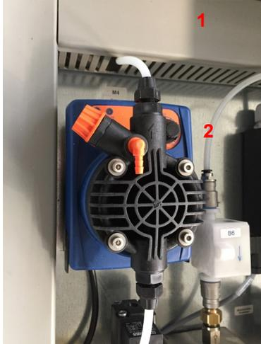
Als Ersatzteil ist nur der Komplette Pumpenkopf erhältlich
